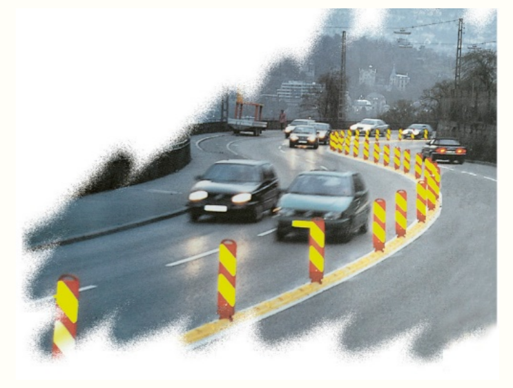
Klemmfix Hindermarkeringer montert på ledeskinne.
