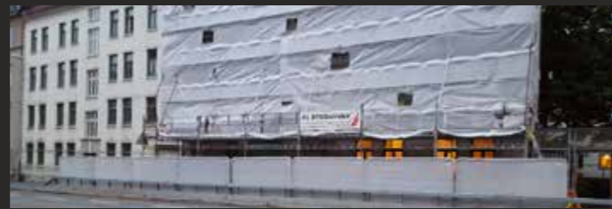
Anleggsgjerde med plastduk
