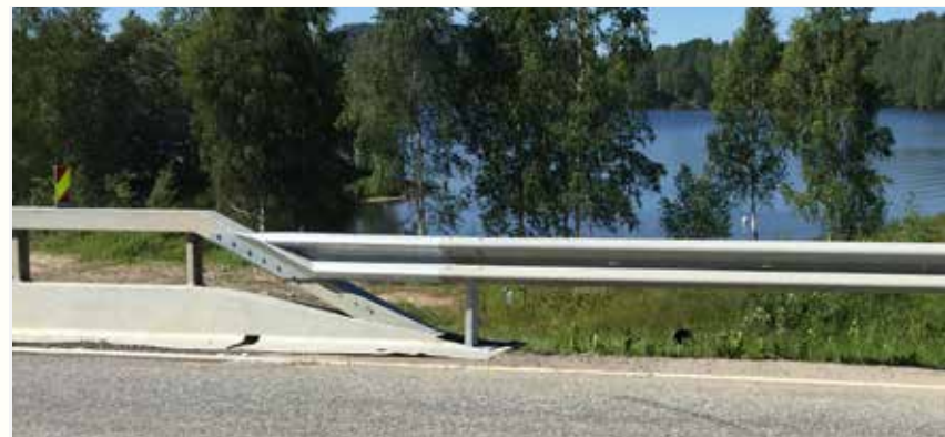
Vegkant; Ensidig overgang VG-W rekkverk
