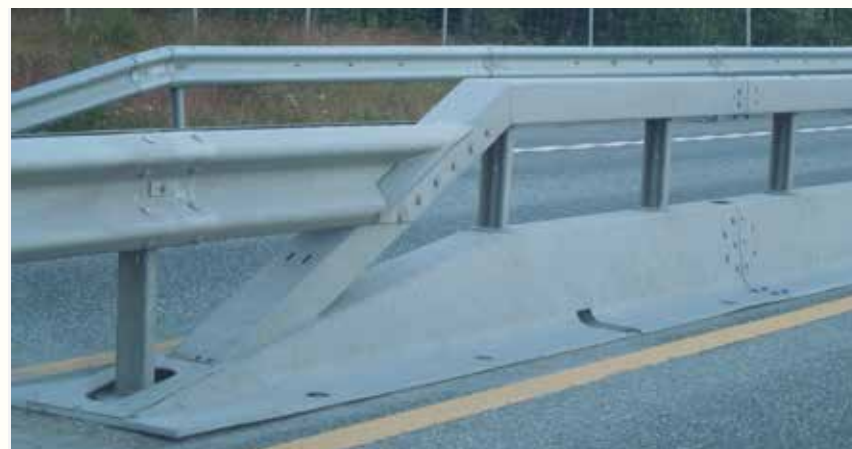
Midtdeler; tosidig overgang VG-W rekkverk
