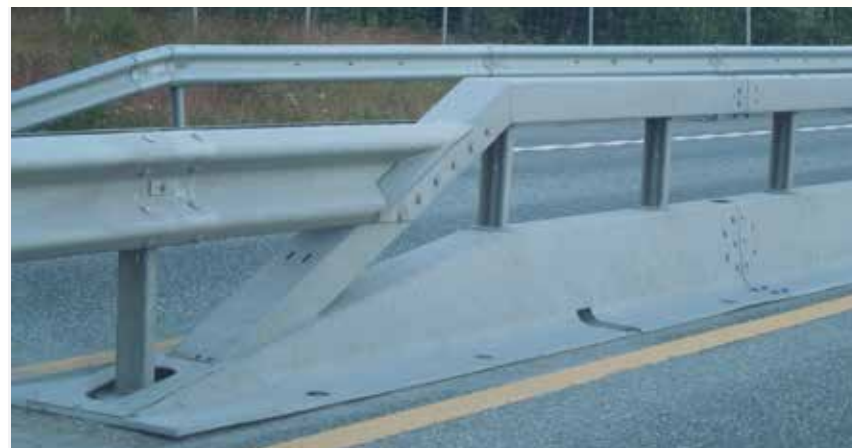
Midtdeler; tosidig overgang VG-W rekkverk
