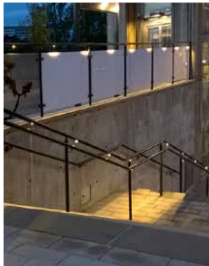
Opti rekkverk med LED-lys
