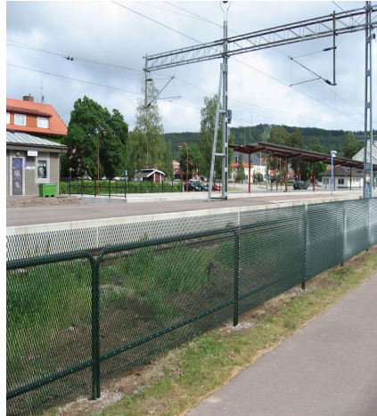
Nett med vertikale masker: Små masker (S) = 32x12 mm
