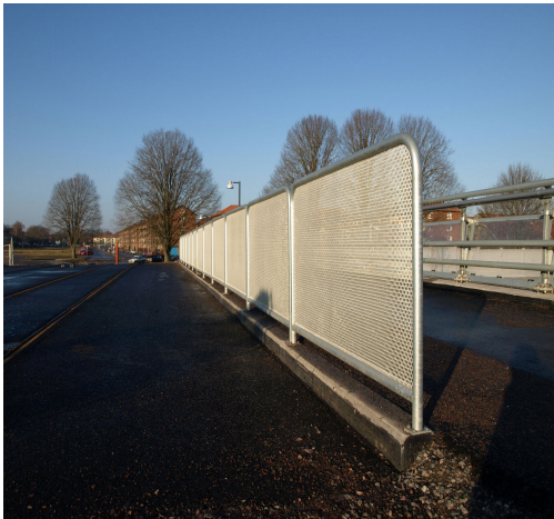
Innfelt nett - Fastmontert og nedstøp
